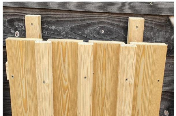
Abmessung: 19x143 mm / Deckellatte 19x56 mm
